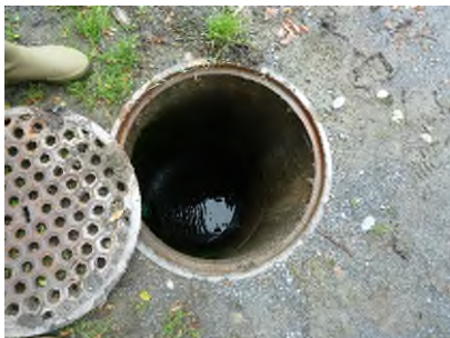
Abb.: Im Sediment von Sammelschächten können sich PSM akkumulieren.
