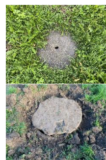
Abb.: Deckel mit offenem Pickelloch und defekte Deckel stellen ein Eintragsrisiko dar.
