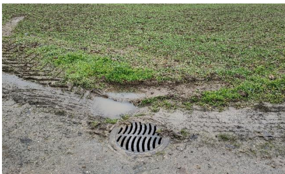
Abbildung 2: Offene Schächte bergen ein Eintragsrisiko von PSM in Gewässer. Zudem fehlt hier ein genügend breiter Pufferstreifen zwischen Schacht und Kultur.
