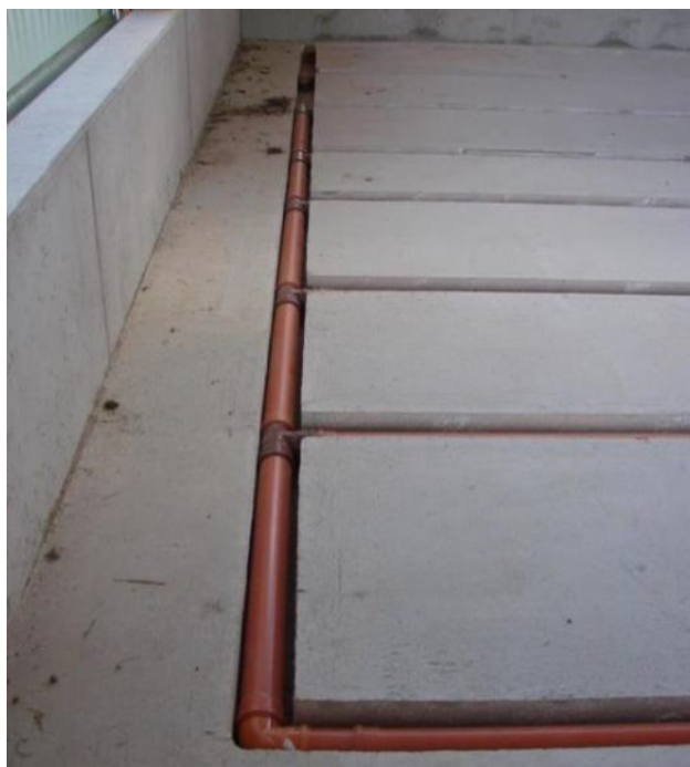
Bilder 2 und 3: Beispiel für ein eingebautes Unterflurbelüftungssystem
