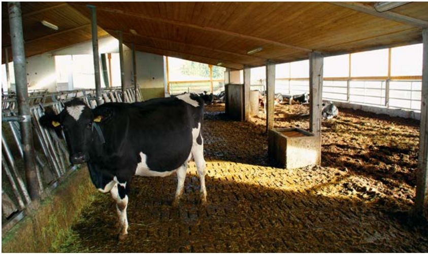
Der ehemalige Anbindestall ist im Neubau integriert und dient heute als Fressplatz. Dieser wird eingerahmt vom Liegebereich und dem Warteraum vor dem Melkstand.
