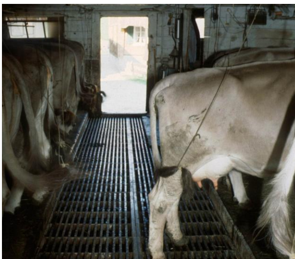
Abb 10 Schwemmkanal als Stallgang
