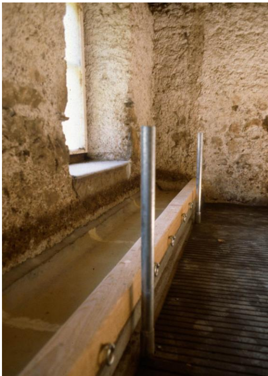
Abb. 2 "Glerner"-Krippe nach Vorschlag Hösli; hier mit Doppelstoss-Anbindung
