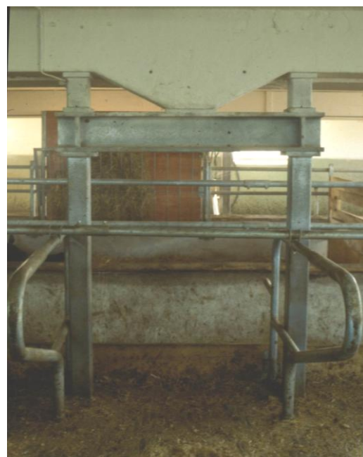
Abb. 21 Zweiseitige Stützen für hohe Deckenbelastung (Freihofer, Zürich)
